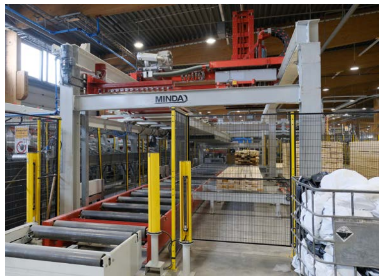
Entstapeln: lagenweise mit Vakuumhebern
