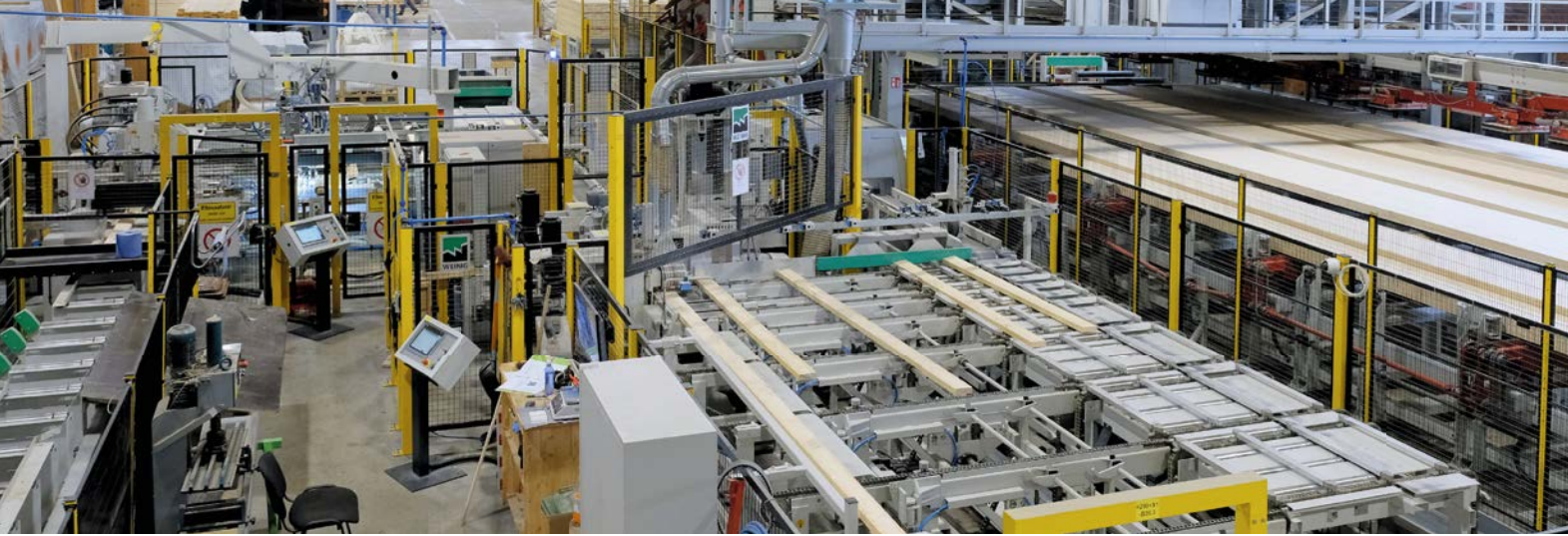
Keilzinkenlinie: Eine Weinig Grecon-PowerJoint 15 verarbeitet die Lamellen zu einem Endlosstrang
